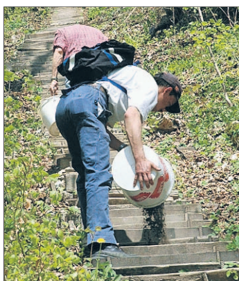
UNERMÜDLICH Roland Neth füllt ausgetretene Stellen auf.
