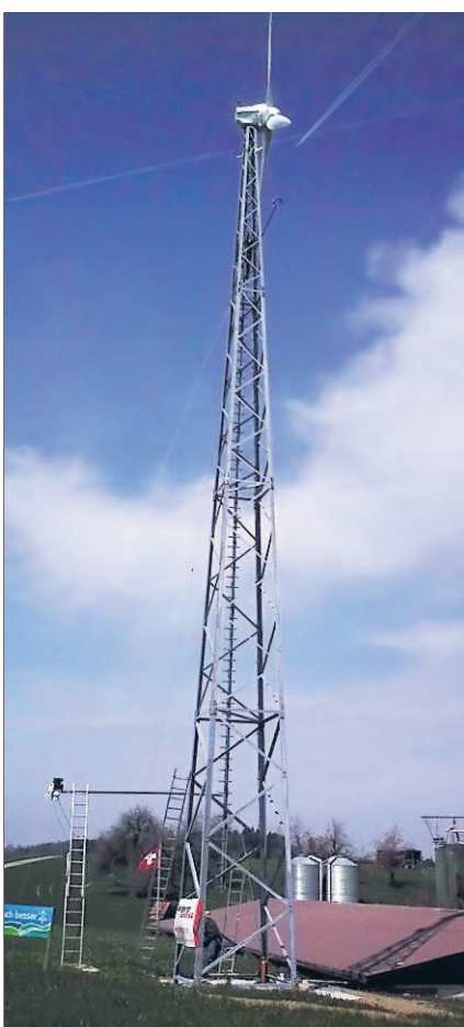
NÜTZIWEID An der Windenergieanlage ist im unteren und oberen Bereich die Wetterstation angebracht. ZVG
